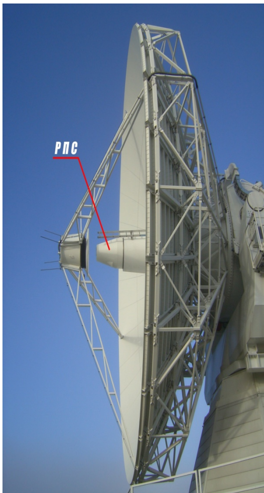
Рис. 1. Общий вид антенны с РПС
