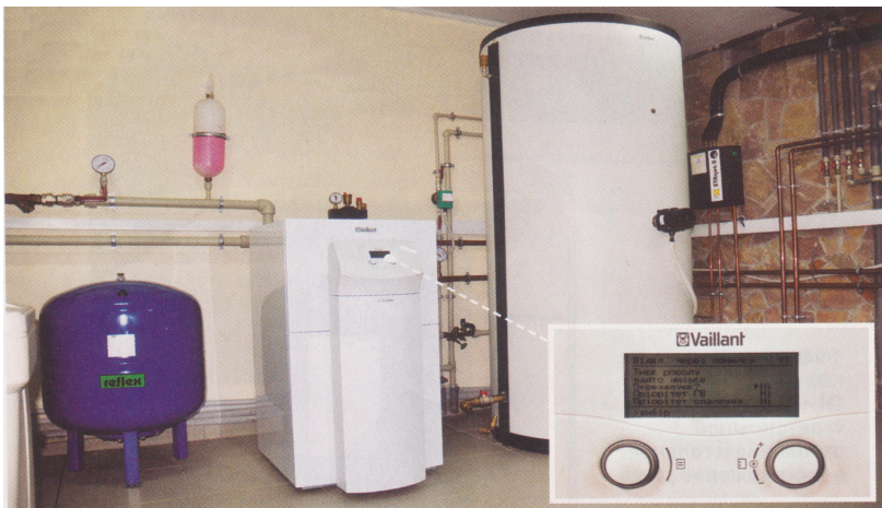
Рис. 4. 22. Обв'язка обладнання теплового насоса
