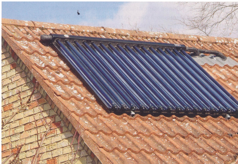
Рис. 3.21. Встановлення трубчатого колектора
