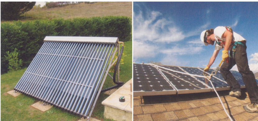
Рис. 3.23. Колектори з оптимальним розташуванням відносно сонця
