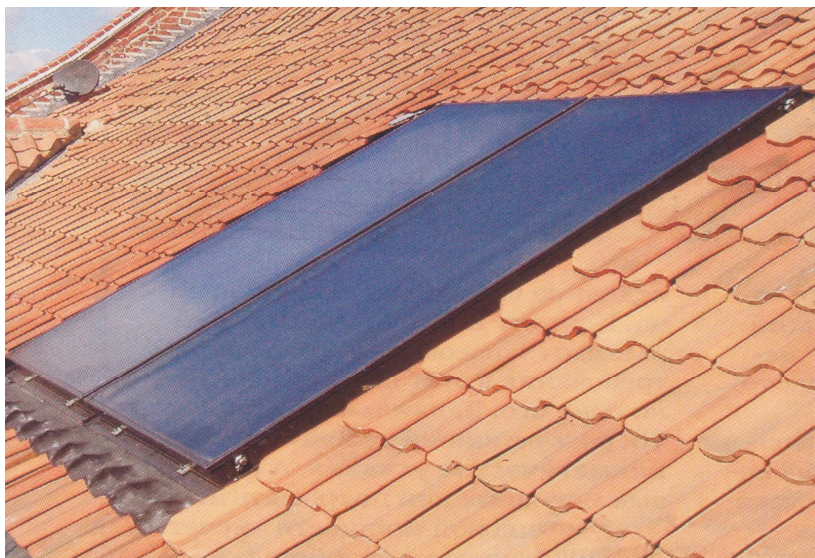
Рис. 3.20. Встановлення плоского колектора
