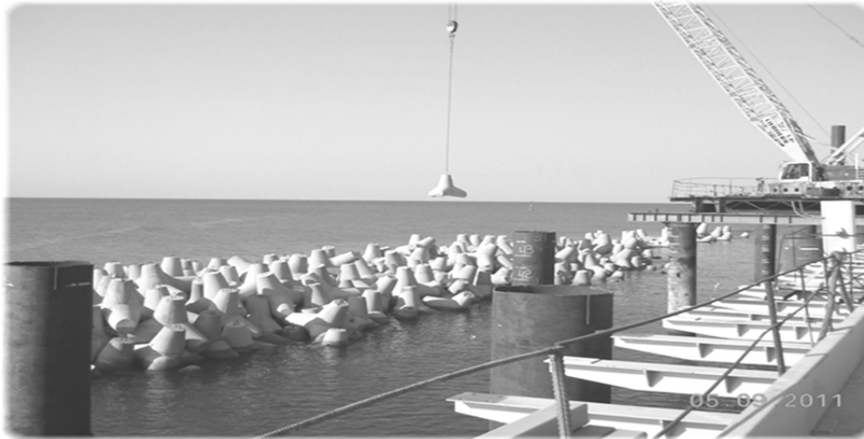
Рис. 6 – Огороджувальна споруда гравітаційного типу (з тетраподів)
