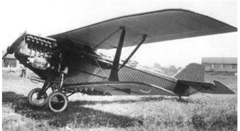
Рисунок 8.2. АНТ-3 – первый боевой цельнометаллический самолёт
