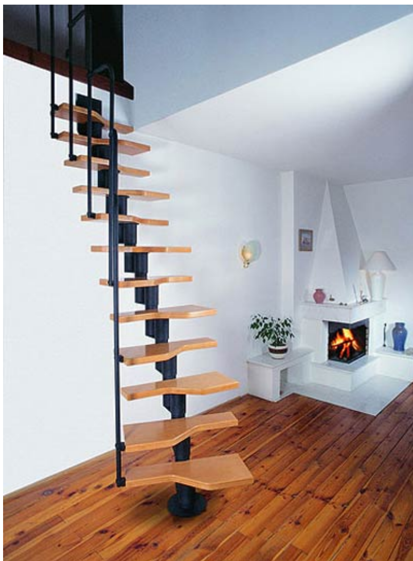
Рис. 5.38. Дерев'яні сходи з металевим косоуром
