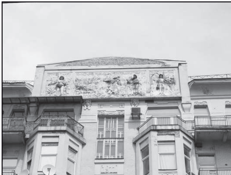
Рисунок 2. Фрагмент фасада, ул.Саксаганского. Июль 2010 г.
