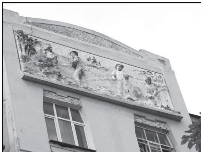
Рисунок 3. Фрагмент фасада, ул.Антоновича. Июль 2010 г.
