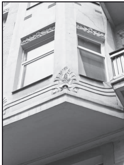
Рисунок 4. Фрагмент фасада, ул.Саксаганского. Июль 2010 г.
