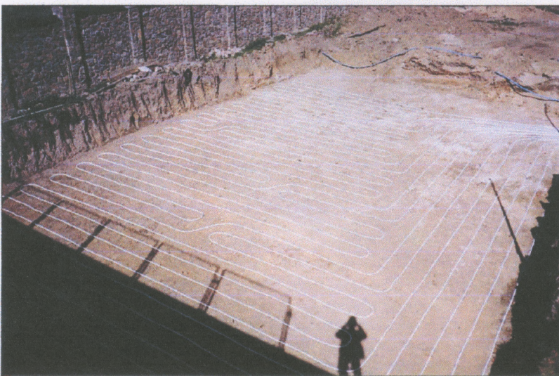
Рис. 4. Фрагмент укладки грунтового коллектора.
