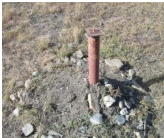
Рис. 3.2. Загальний вид ґрунтового репера
