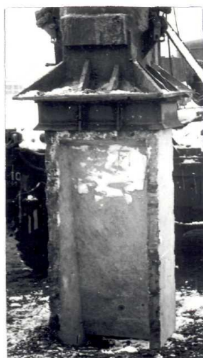
Рис.13. Паля СВД в процесі забивання
