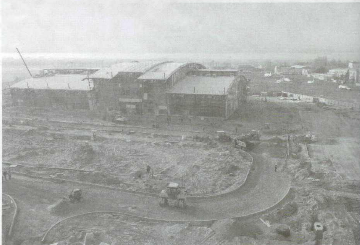
Рис. Завершення реконструкції ЗПП у Жулянах на 2,5 км.
