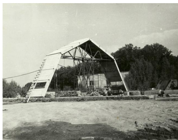
Рис.4. Загальний вигляд спробного фрагменту поперечника безкаркасної будівлі
