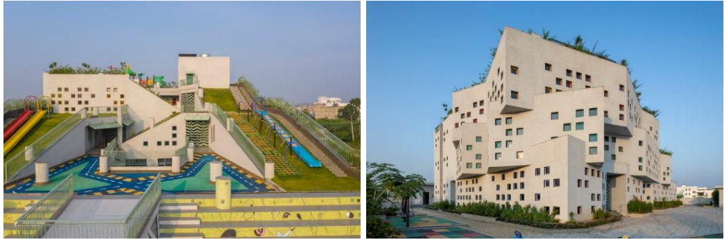
Рис.1.16. Школа в Сангамі, Індія, 2018, арх.бюро SferaBlu Architects.
