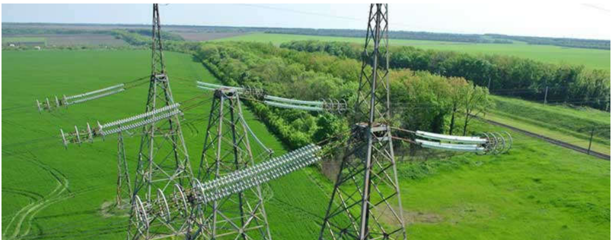
Рисунок 1.2 Анкерна опора ЛЕП
