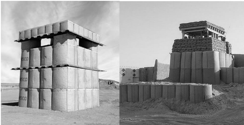
а) б) рис.2 (а,б). Приклади швидко монтованих споруд з габіонів – укріплені вишки блокпостів
