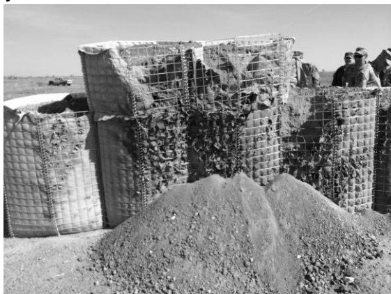
рис.3. Габіони після попадання з гранатомету
