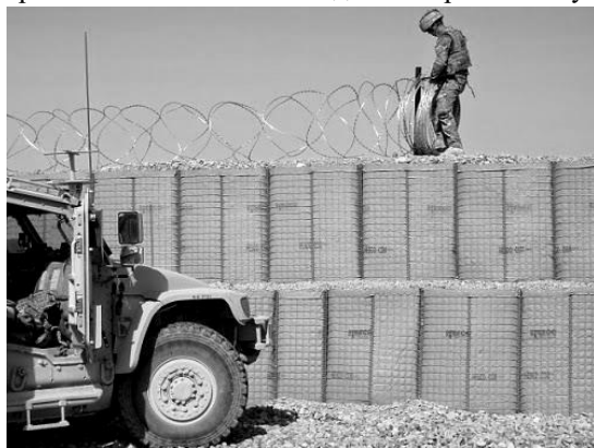
рис.4. Встановлювання колючого дроту над стіною габіонів
