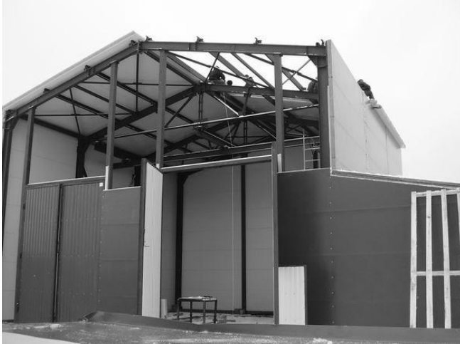
рис.1. Швидко монтована будівля з сандвіч-панелей
