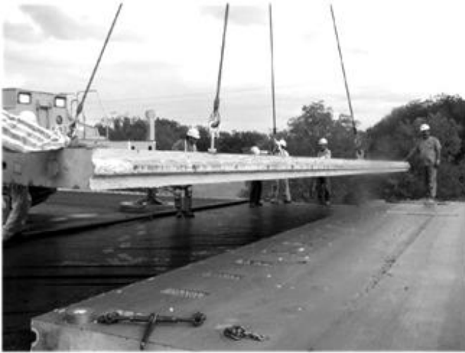
рис. 2. Подача бетонної плити збірного типу на дорожно-земляне полотно з підсипанням дренавального піщаного шару, вкритого поліетиленовою плівкою
