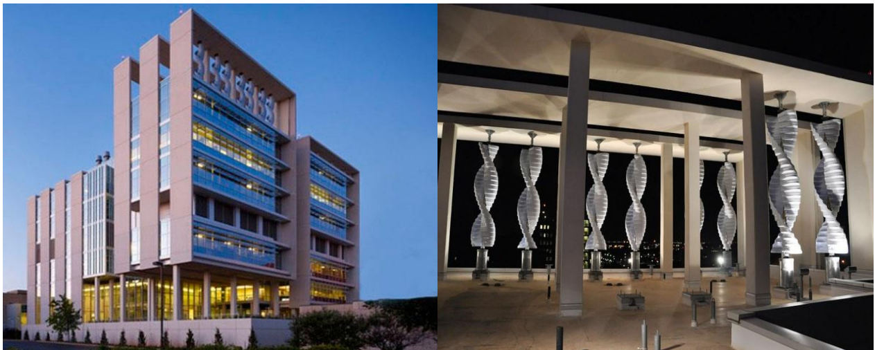
Рис. 2 - ВЭС інтегрована в дах Оклахомського Медичного дослідницького фонду(OMRF)
