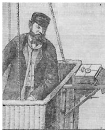
Рис. 2.19. Кріплення фотопристрою на кошику повітряної кулі РТТ
