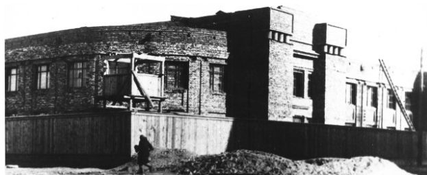
Рис. 9.21. Недобудована будівля спортклубу в Красноярську, де розмістили фабрику №6
