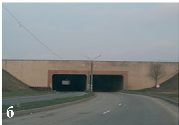
Рис. 3. Тоннели под основными элементами аэродромов: а - Hartsfield-Jackson Atlanta International Airport [2]; б - аэропорт «Симферополь» (Крым)
