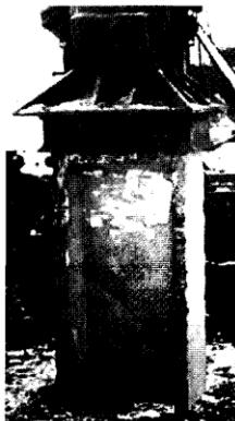
Рис.13. Паля СВД у процесі забивання.
